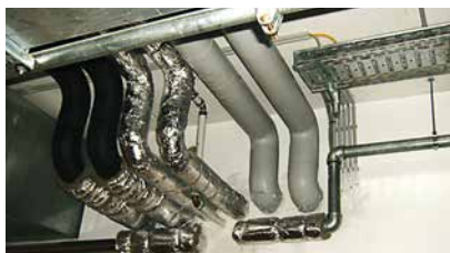
Isolation de conduites
