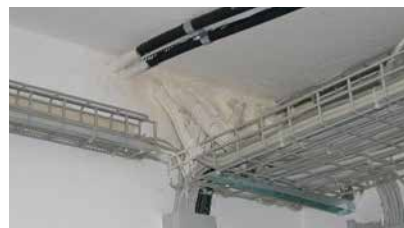
Isolation de câbles
