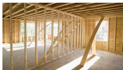
– Parois et plafonds
